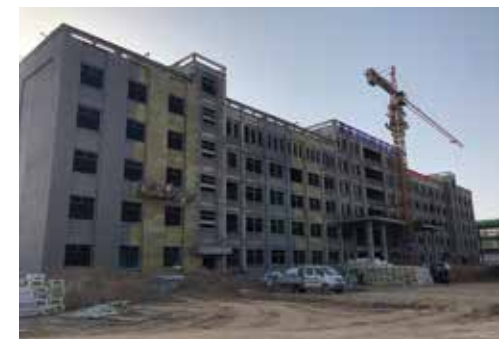
正在建设中的石化中学
