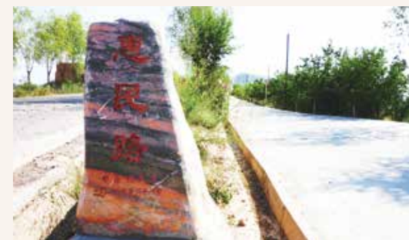
援建后的布楞沟村通村硬化路
