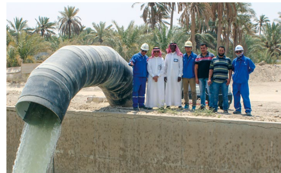
沙特农业部净化水输水工程项目投产试运行通水
