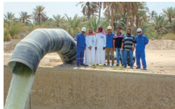
中国石化承建的沙特农业部净化水输水工程正式建成投用，惠及该区域逾100万人，每天输送的净化水已经成为哈撒绿洲地区灌溉用水的重要补充
