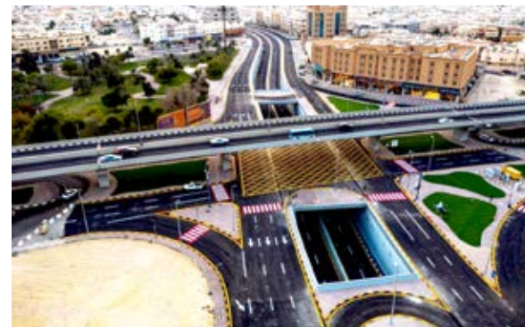
中国石化承建的达曼28号街通道立交桥项目，彻底解决该路段拥堵问题，车辆通过该区域从原来几小时缩短至5分钟
