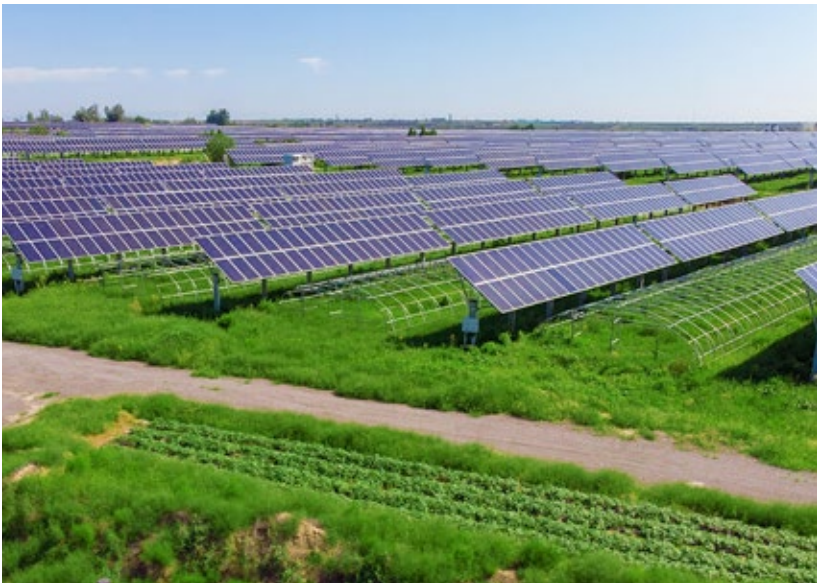
中国石化新星冯雷光伏电站
